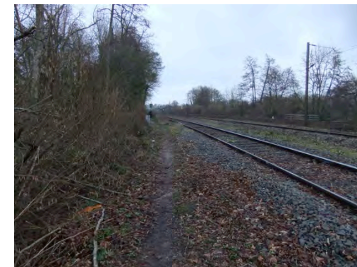
Cheminement le long des voies ferrées (Source : AUDC)
