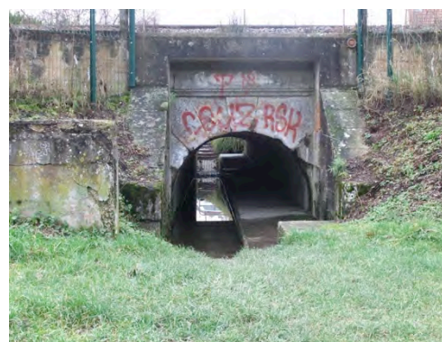
Passage sous les voies ferrées (Source : AUDC)
