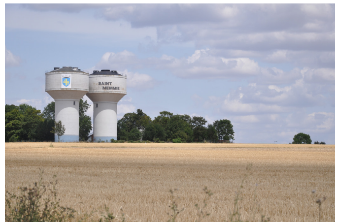
Châteaux d'eau du Moulin Picot à Saint-Memmie
