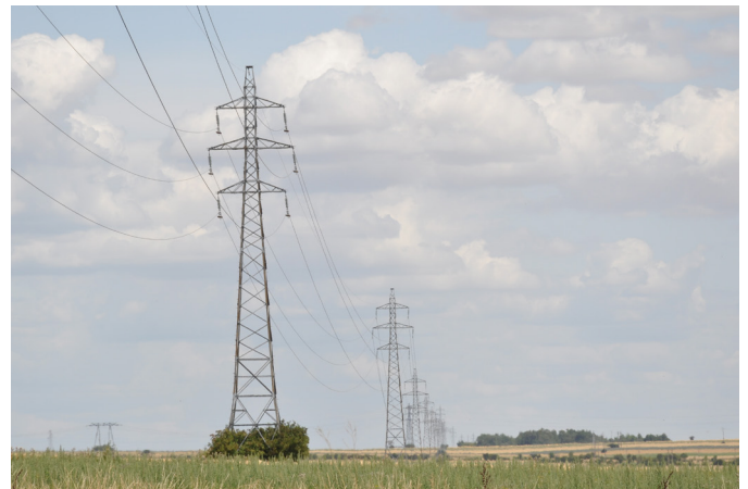
Ligne électrique EDF à Recy
