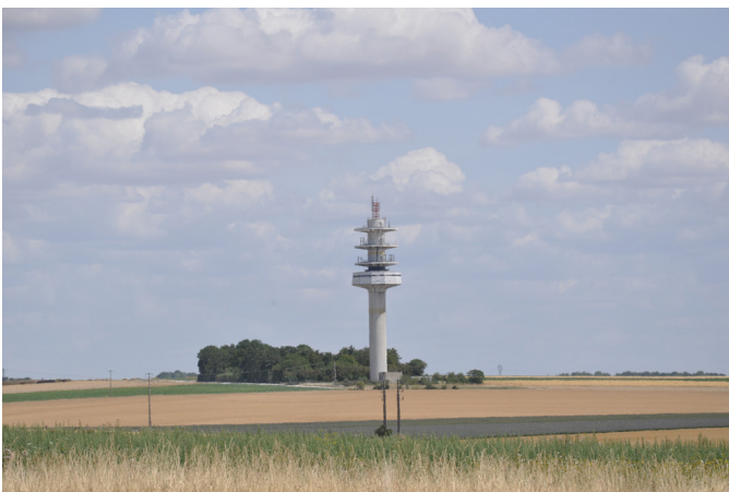
Tour hertzienne à Saint-Martin-sur-le-Pré
