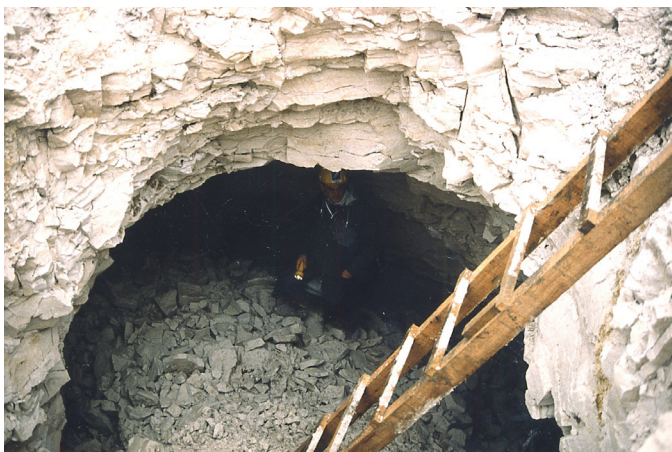
Cavités (photo : BRGM)
