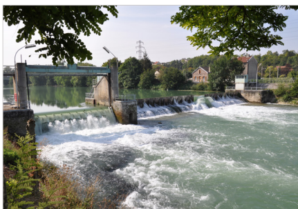
Barrage de la Marne, Châlons-en-Champagne © Audc
