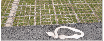
Dalles alvéolaires engazonnées, Lidl, Châlons-en-Champagne © Audc
