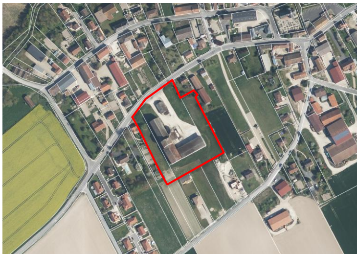
Vue aérienne d'un silo en friche à Francheville (CCMC)
