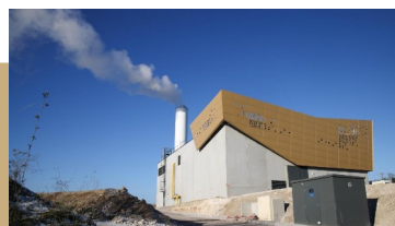
Réseau de chaleur de Châlons-en-Champagne
