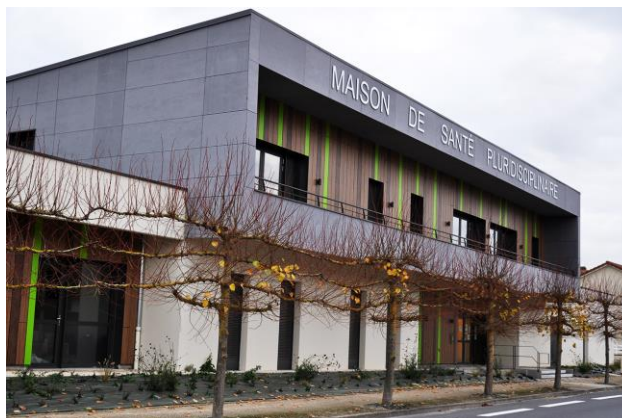
Photo 1 : maison de santé pluridisciplinaire à Saint-Martin-sur-le-Pré – ©AUDC - 2020
