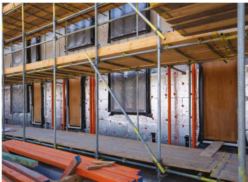
⇒ Isolation extérieure d'un bâtiment d'habitation © Éric Mclean
